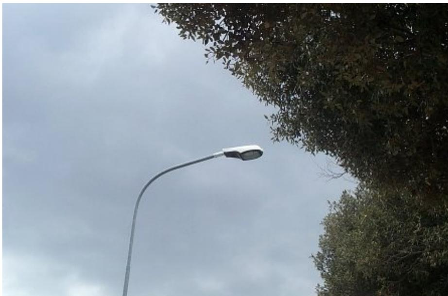
Figura 26 - Lampione stradale originariamente con coppa sporgente prismata sostituita con chiusura in vetro piano temperato.
