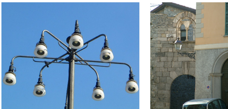
Fig.4 – Esempio di messa a norma di impianti d'illuminazione d'epoca: con semplici e poco costose schermature (foto di sinistra) oppure, nel caso della foto di destra, ricondizionando antiche lanterne e facendole rientrare nella deroga dei 15 cd/klm a 90^\circ ed oltre . [Immagine fornita da CieloBuio]
