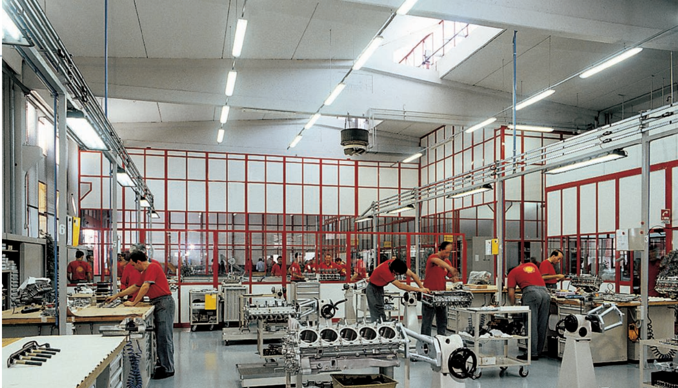
Figura 2 - Interno degli stabilimenti Ferrari Spa, a Maranello (MO), illuminati con plafoniera Eterna stagna (IP65) a 2 o 3 tubi fluorescenti (cortesia: Disano Illuminazione)
